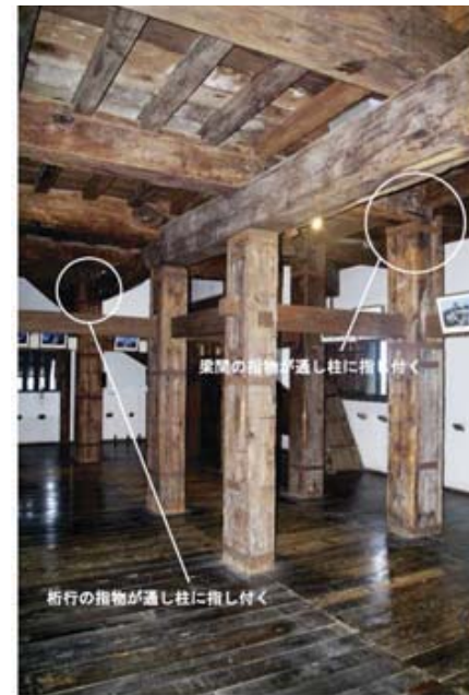
松江城天守3階 桁行と梁間の指物 (写真: 著者撮影)
