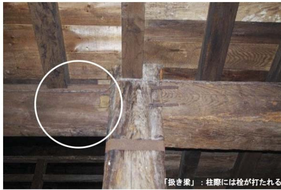
松江城天守2階床梁（著者撮影）
