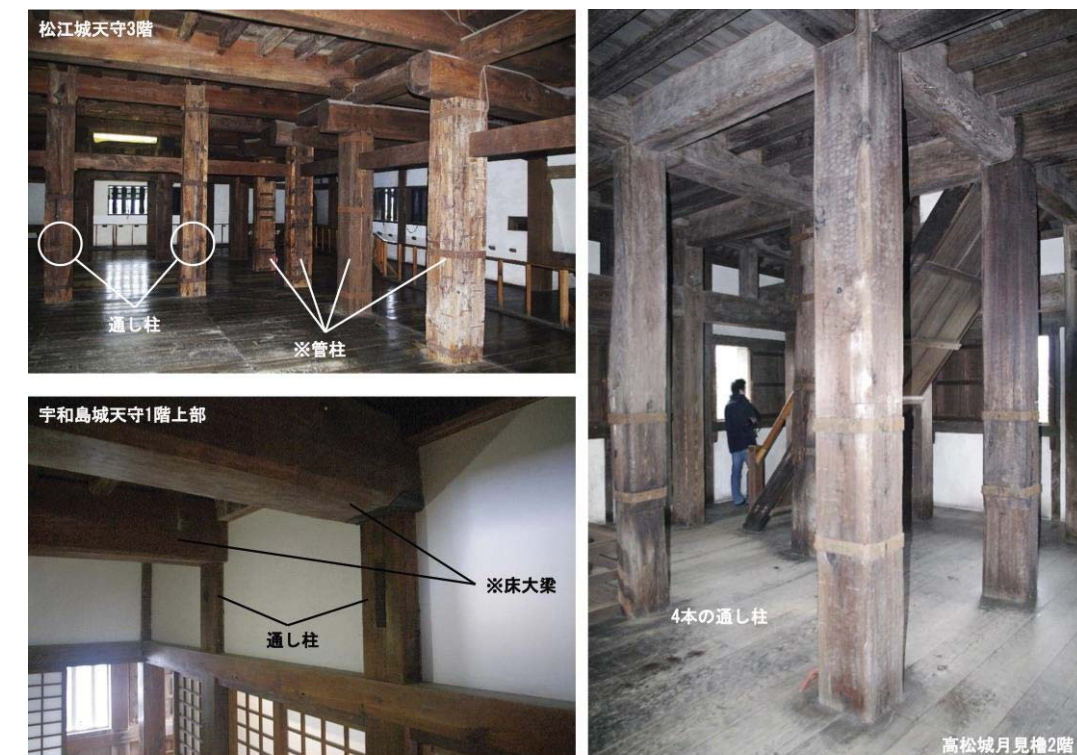
各類型の「通し柱」(写真:著者撮影)
