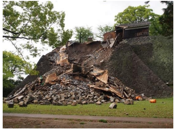
地震による石垣の崩壊
