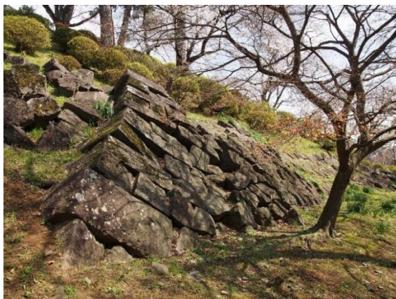
小田原城本丸南面石垣の崩壊遺構
