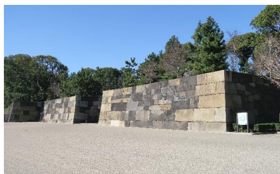
修復された石垣
